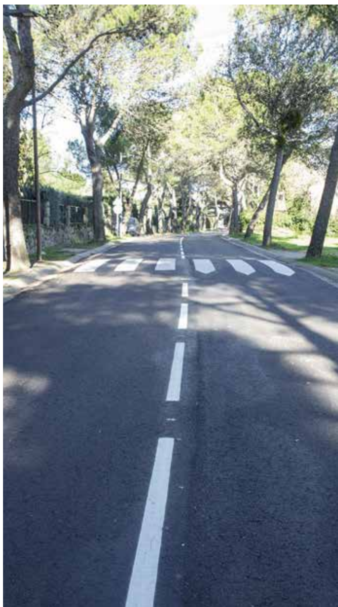
Asfaltado en Las Lomas
