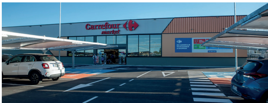
Carrefour en La Cárcava
