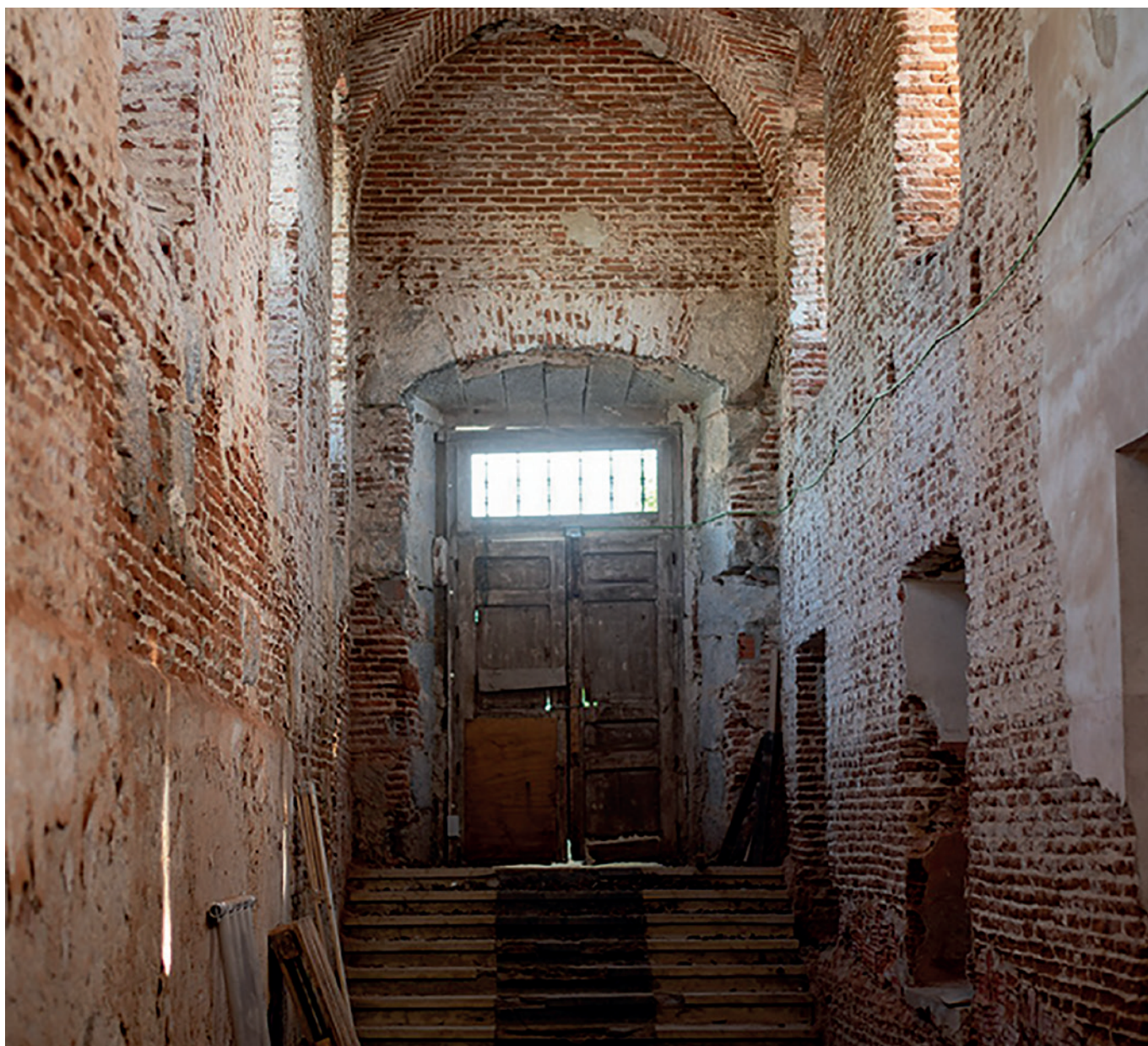
Zona del Palacio que será rehabilitada
